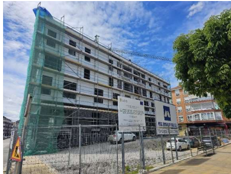
Obras del Centro de Acogida, Centro Cívico y Alojamientos en Régimen de Alquiler Temporal
