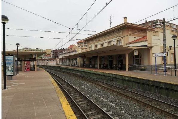
Estación de Torrelavega-Centro. Línea de ancho métrico.
