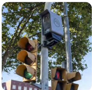
Radar Láser TruCAM II en cabina compactas de poste lateral integrada en mobiliario urbano no invasivo
