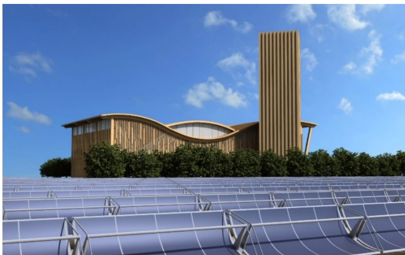
Figura 1. Central de generación red de calor de Alcalá de Henares.
