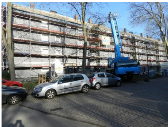
Figura 2. Rehabilitación de fachada en Colonia por Dewag, socio de GrowSmarter.
