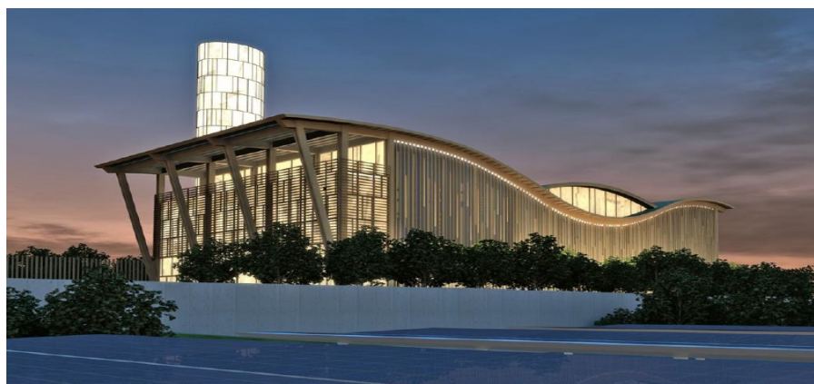
Figura 5. Vista de la estación Brunete District Heating.
