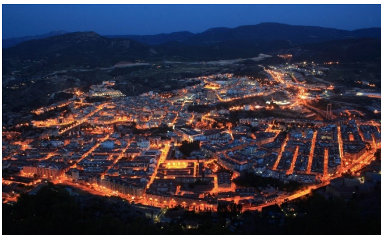
Figura 2. Ciudad de Alcoi antes de la realización del proyecto de renovación de alumbrado.
