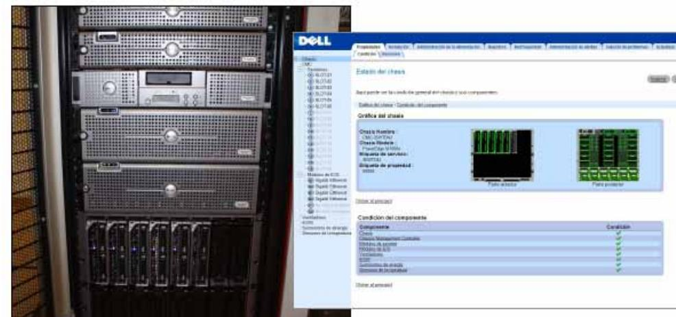
Ilustración 12: Imagen del armario de servidores del nuevo CPD de la Diputación de Soria. A la derecha, un pantallazo del sistema de gestión del CPD que permite visualizar el estado de la red de servidores, de especial importancia para monitorizar aquellos servidores que alojan servicios publicados en Internet y que deben estar operativos las 24 horas del día.
